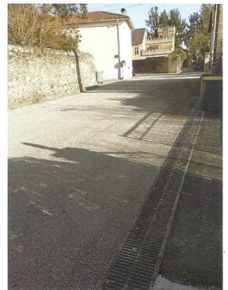
Un caniveau d'écoulement a été réalisé afin de mieux collecter les eaux de pluie et la chaussée a été refaite.
