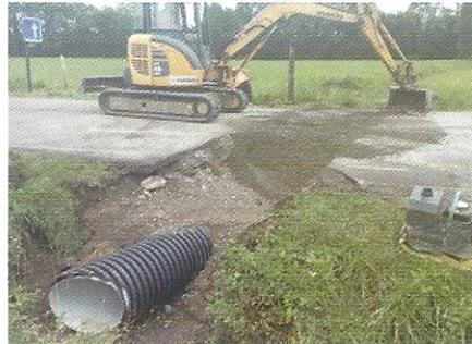
Nous avons profité de la réfection de la route d'Assat par le département pour redimensionner le buse d'écoulement passant sous la RD 215.
