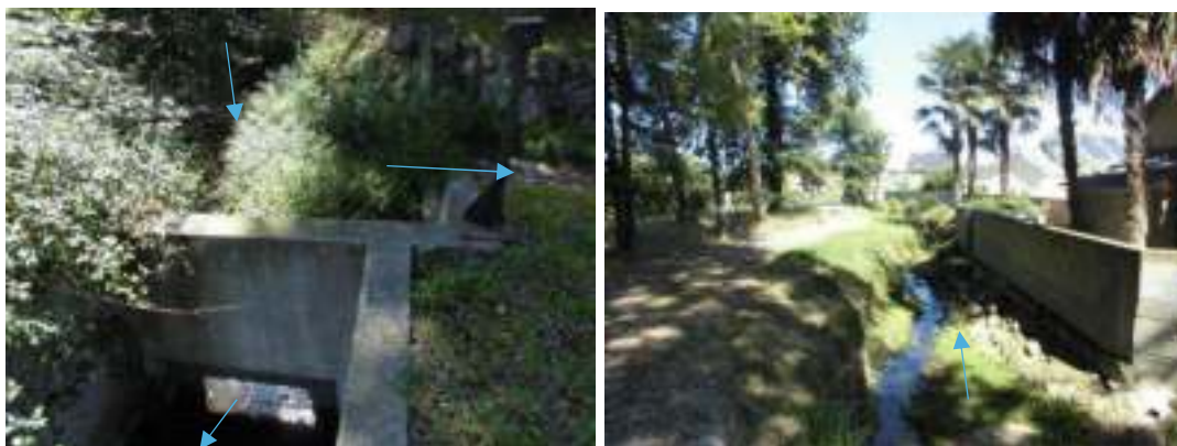
Figure 40 : Le Lou Bouey – Ouvrage de répartition et bras droit en aval
