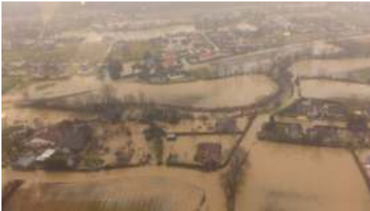
Figure 1 : Inondation à Idron en janvier 2014 (source SDIS 64)
