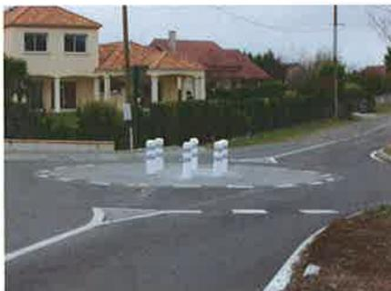
La pose de quilles au centre de l'aménagement afin d'empêcher le franchissement vient d'être réalisée.
